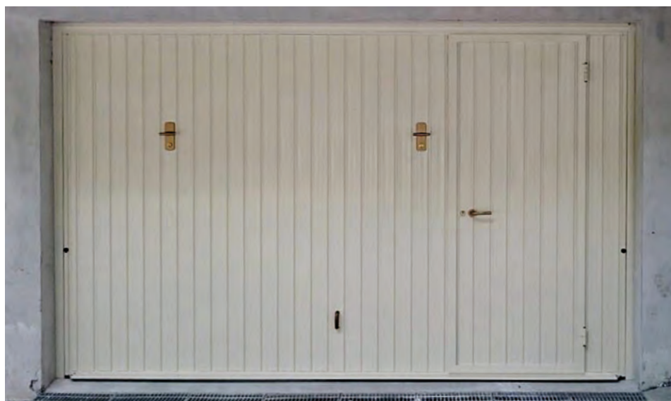
Basculante coibentata in lamiera con portina Ral 1013 motorizzata
